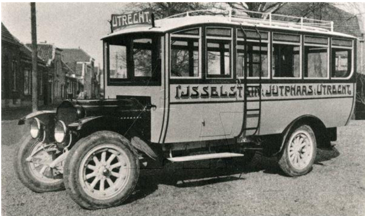
Lijnbus van Jan van de Wijngaard, waarschijnlijk van het merk 'White', die in september 1924 onder nummer 3 in dienst kwam. Opname omstreeks 1925, gezien naar het noorden, vanaf de Poortdijk. In het midden een vast trapje ten behoeve van het deponeren van de bagage op het dak. Op de bus de tekst "IJsselstein - Jutphaas - Utrecht".
